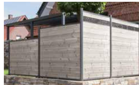
SYSTEM THERMO-HOLZ MASSIV nach Bewitterung.
